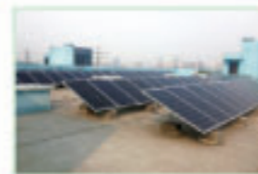
25KWp分布式光伏电站
