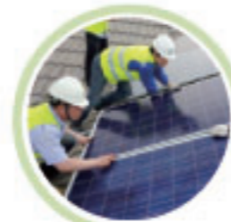
2.5KWp别墅区分布式光伏电站
