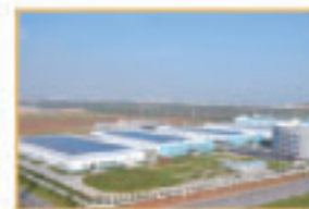
3.008MWp分布式光伏电站
