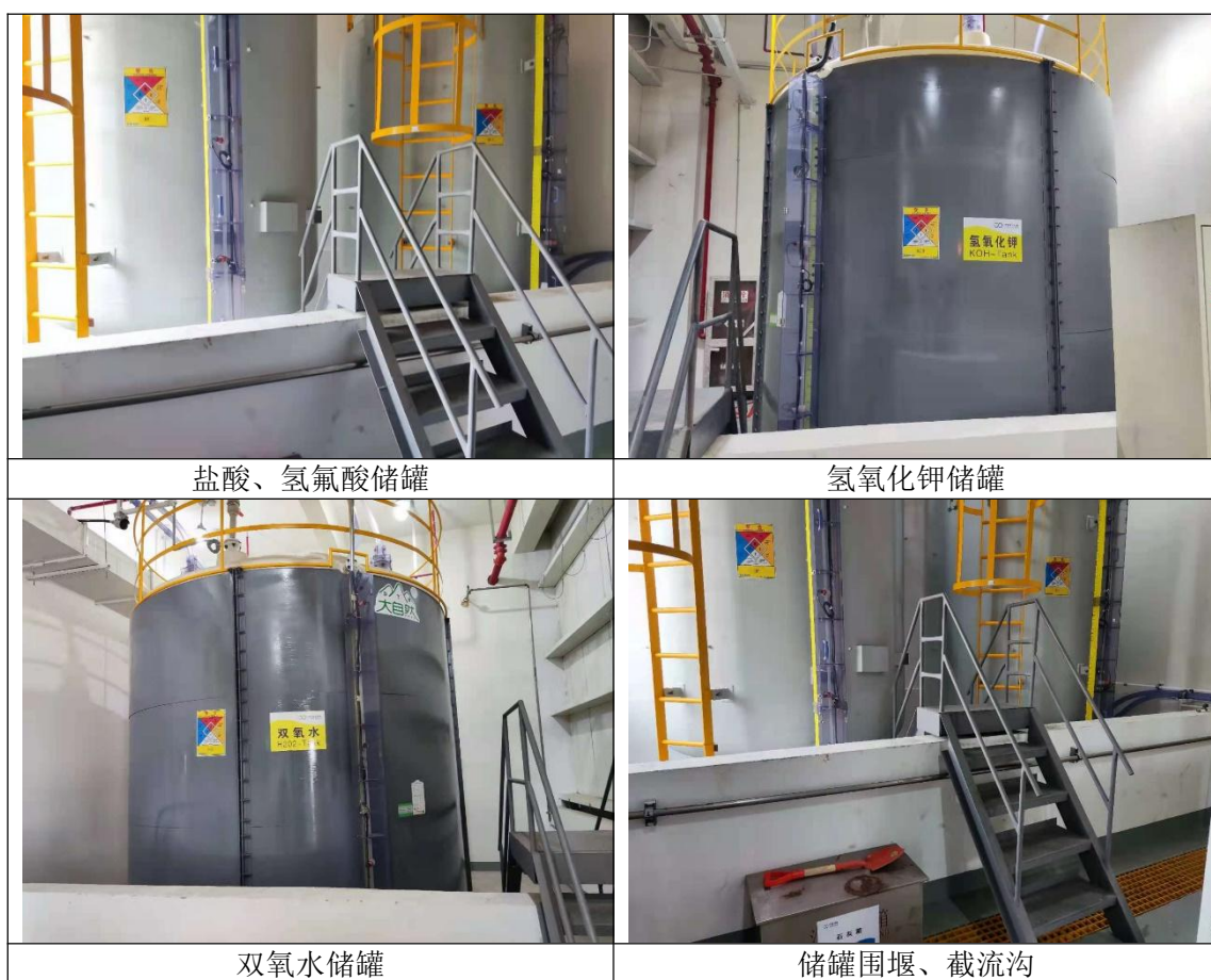
图 5.1-2 C1、C2 车间储罐踏勘图
