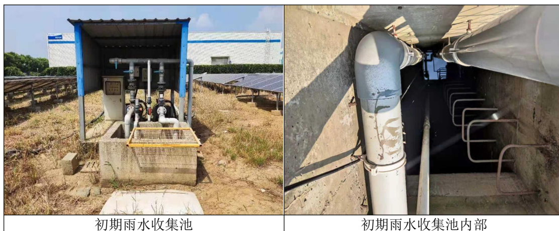
图 5.1-5 初期雨水收集池踏勘图
