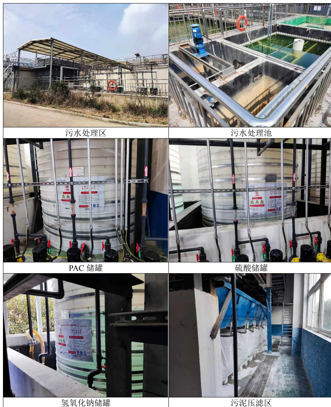
图 5.1-5 污水处理站踏勘图
